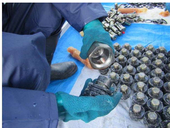
圧索装置組み立て
